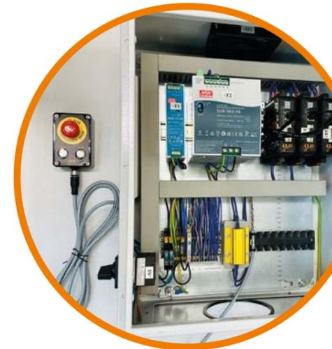
Schaltschrank-Installation mit frei positionierbarem externen Not-Aus-Schalter
